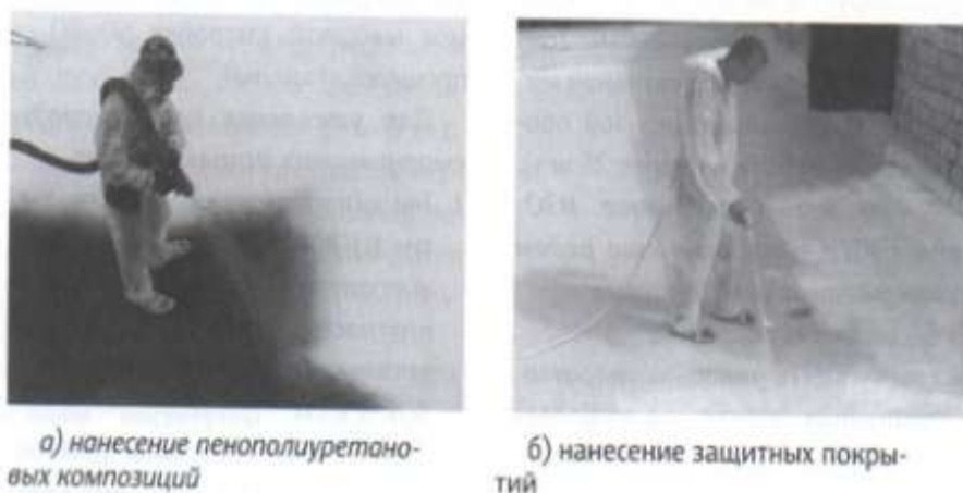
Рисунок 3. Устройство теплогидроизоляционного покрытия ИЗОФРАМ УТГИ.
